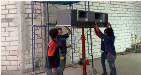
งาน ติด S-OASIS ร้าน MOM'S TOUCH ระบบ VRF ยี่ห้อ LG จำนวน 1 SYSTEM 3 GCU 1CDU
